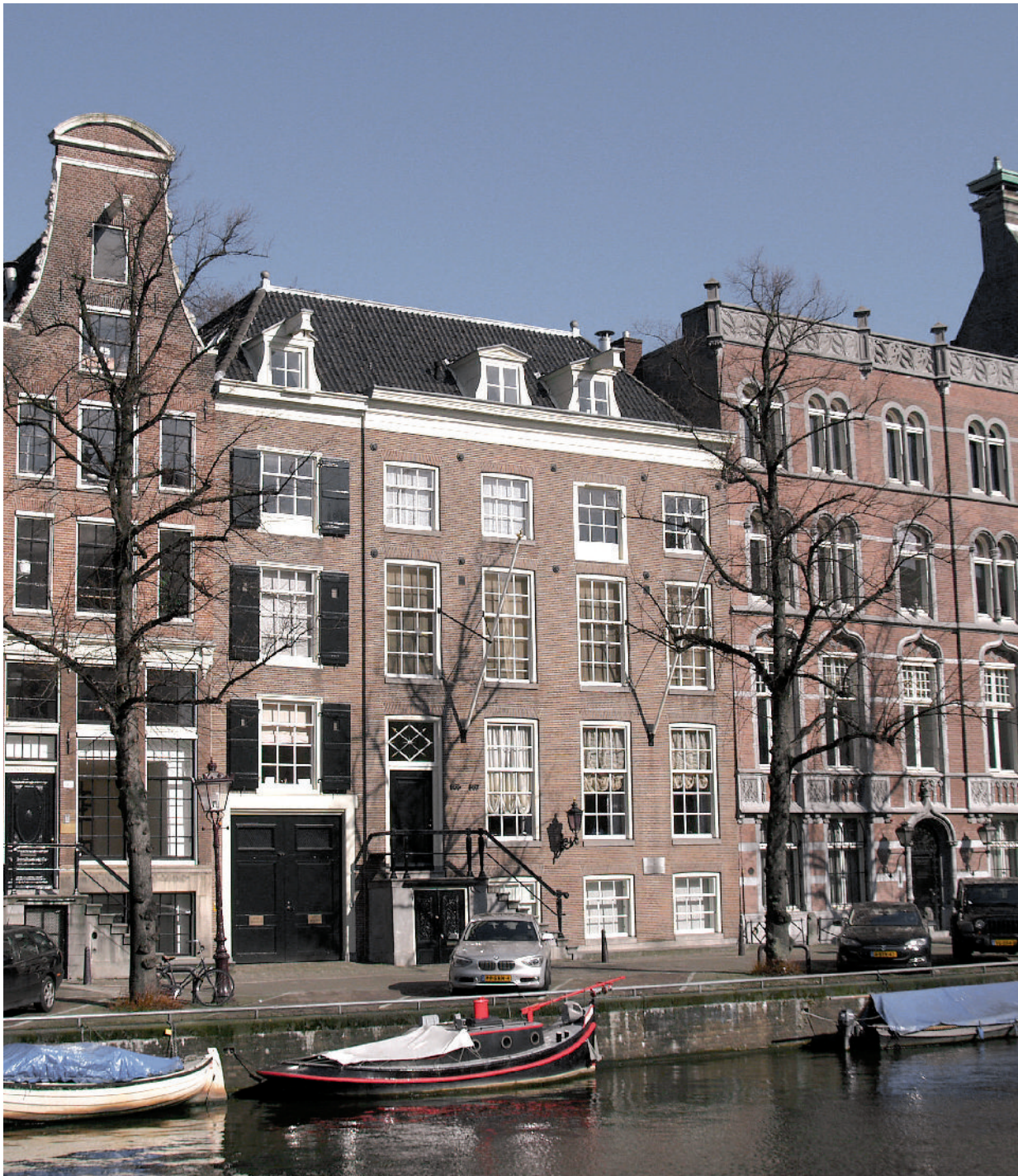
Keizersgracht 567, het huis waar op 13 oktober 1944 de Stichting werd opgericht door vertegenwoordigers van 21 landelijke verzetsorganisaties. Het zeventiende-eeuws pand van de Nederlandsche-Indische Escompto-Maatschappij is gelegen tussen de Nieuwe Spiegelstraat en de Vijzelstraat.
