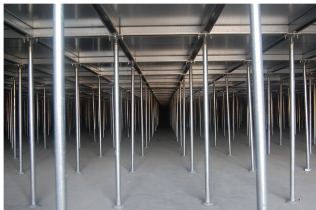
De verhoogde vloer van onderen gezien.
