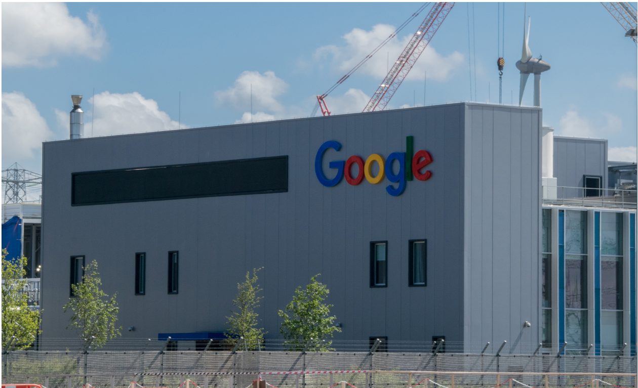
Een hyperscale datacenter in de Eemshaven.
