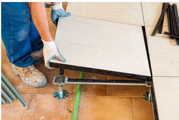
Het aanleggen van een verhoogde vloer in een datacenter.
